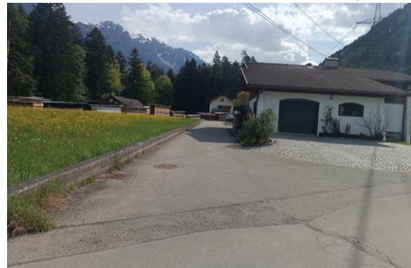
Foto vor Grundstück-Nr. 558/3, Blickrichtung Osten
